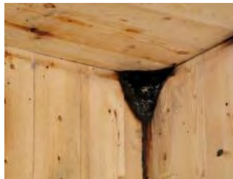
(d) corner joint at ceiling and W1 and W4 walls
