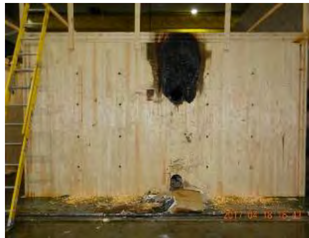
(f) W4 exterior surface
