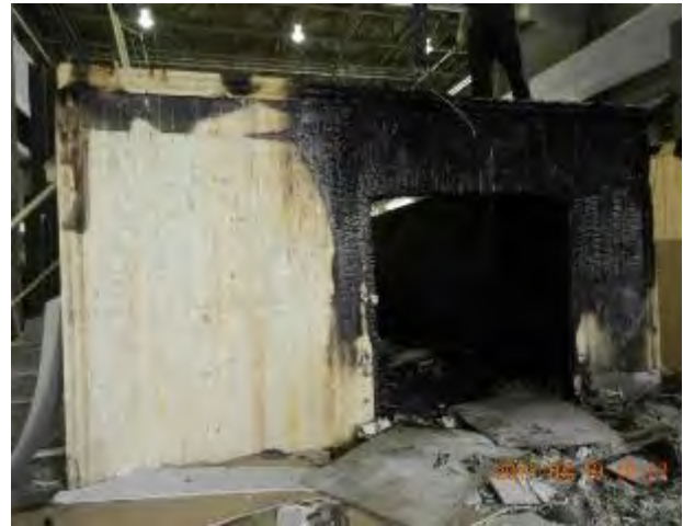
(d) W2 exterior surface
