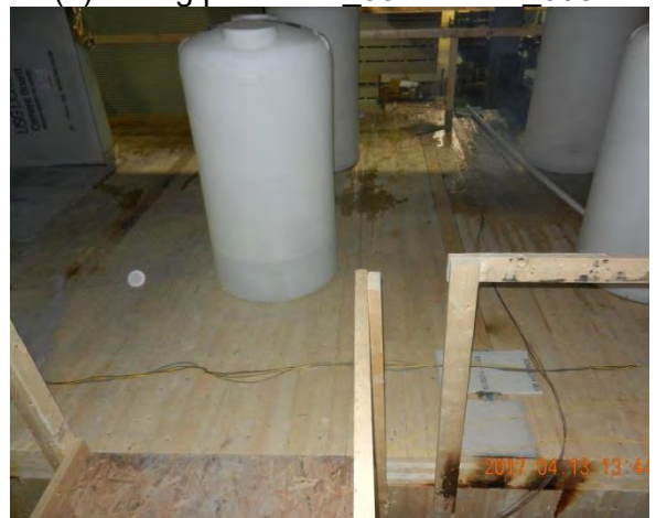
(d) ceiling panels 11_006 and 11_007
