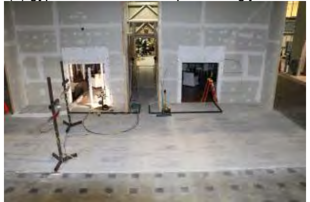
(d) W2 exterior wall with extension
