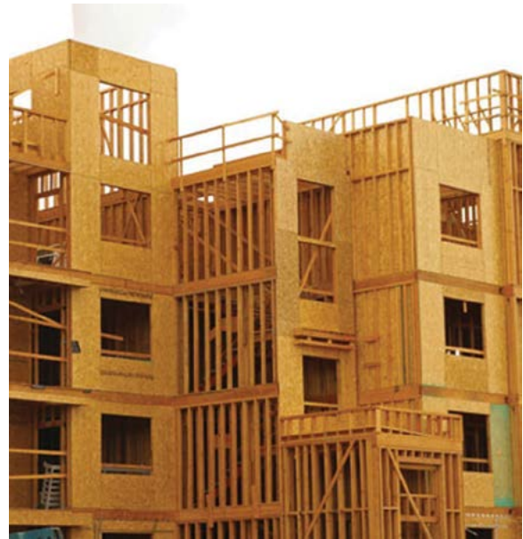
Figure 42—Stud wall framing
